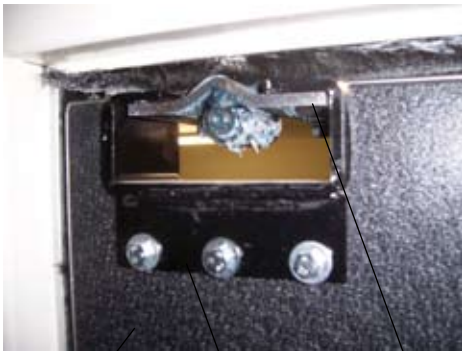
Door Panel Top Hinge Top Hinge Pivot Plate
